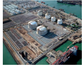
Fuente: https://www.sedigas.es/imagenes | Regasificadora Barcelona, Enagas
