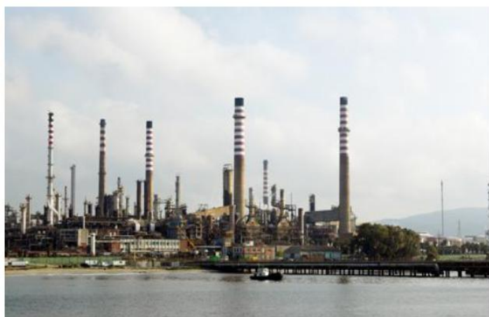
Planta de cogeneración de Cepsa en Lubrisur (Algeciras)
