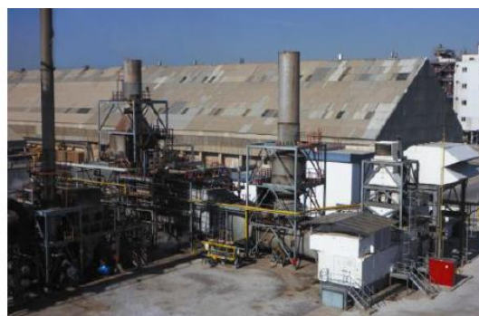
Planta de cogeneración de UBE Chemical en Castellón
